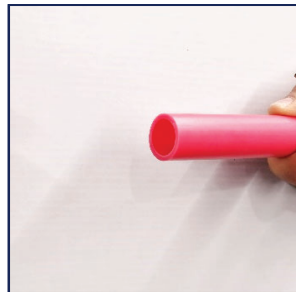
Realiza un corte recto en el tubo PEX
