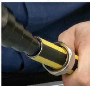
Inserte el avellanador en la tubería, haciendo un movimiento circular. Una vez posicionado a tope, gírelo 3 veces en la misma dirección para rectificar la circunferencia y biselar el interior de la tubería para lograr un ensamble correcto con la espiga y o-rings de la conexión.
