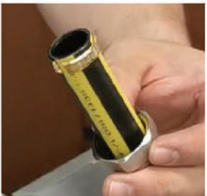
Separe los componentes de la conexión, desenroscando la contratuerca y liberando el anillo truncado. Introduzca la tuerca y el anillo en la tubería.
