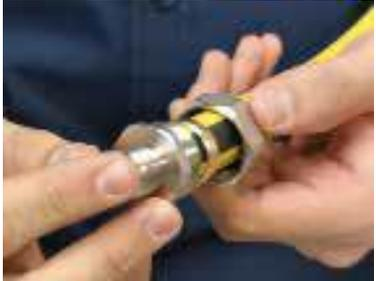
Inserte la conexión dentro de la tubería hasta el tope y deslice anillo y tuerca hacia la conexión.
