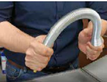
En caso de requerirlo, doble la tubería utilizando el resorte doblador. Esto le permitirá cambios de dirección sin utilizar conexiones en codo.
