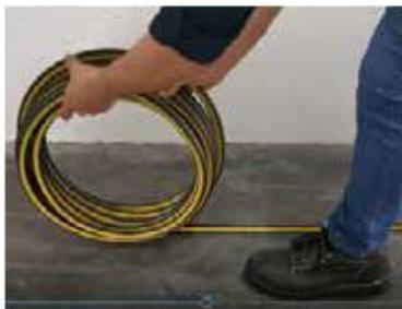
Para comenzar con la instalación, desdoble la tubería, apoyando la bobina en el piso para lograr que la tubería se desenrolle lo más recta posible.
